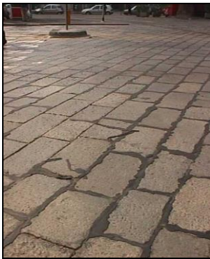
Figura 14: Spandimento di legante sul massello
