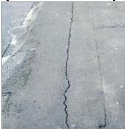
Figura 7: Schema di fessurazione longitudinale
