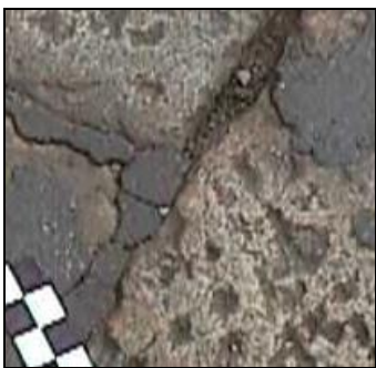
Figura 13: Asportazione di sigillante dai giunti
