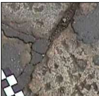
Figura 13: Asportazione di sigillante dai giunti
