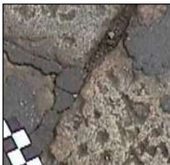
Figura 13: Asportazione di sigillante dai giunti
